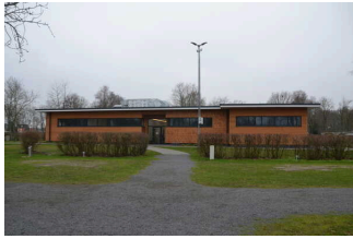
Sanitärgebäude S1 (Sternengarten)
